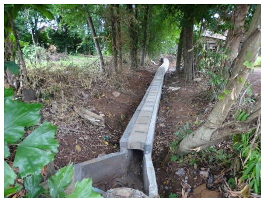
ก่อสร้างรางระบายน้ำคอนกรีตเสริมเหล็ก ซอยบ้านนายเงิน แก้วผงสุข หมู่ที่ ๑ บ้านน้ำใส
