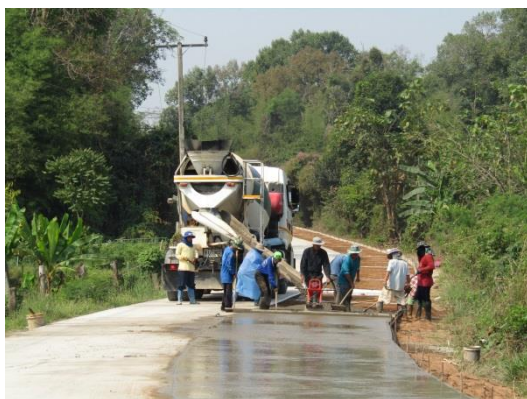
ก่อสร้างถนนคอนกรีตเสริมเหล็ก รพ.สต.บ้านคุ้ม-หมู่ ๖ บ้านข้าป่าหวาย
