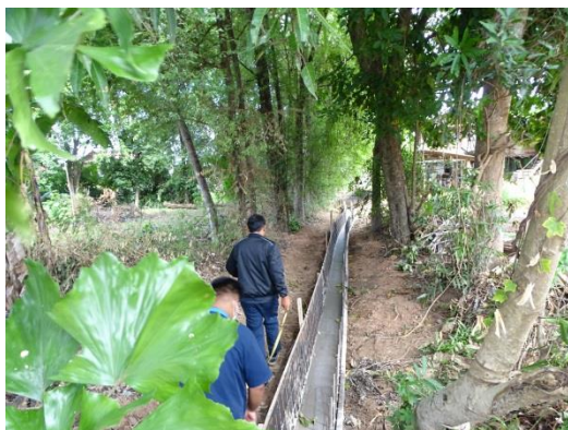
ก่อสร้างรางระบายน้ำคอนกรีตเสริมเหล็ก ซอยบ้านนายเงิน แก้วผงสุข หมู่ที่ ๑ บ้านน้ำใส
